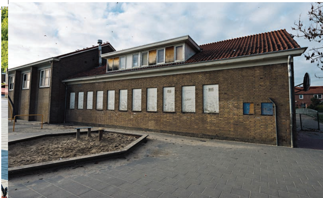
De gymzaal uit 1955 die er al jaren verpauperd uitziet zal eindelijk in 2022 worden vervangen
